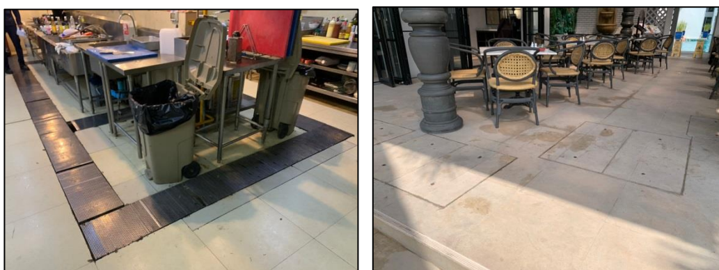
รูปที่ 3-19 ท่อระบายน้ำภายในโครงการ
