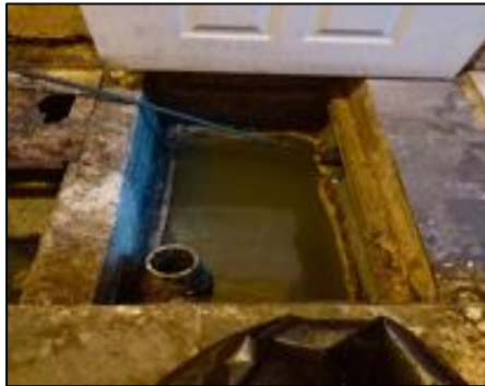
รูปที่ 3-7 เจ้าหน้าที่ทำความสะอาดบ่อดักไขมัน
