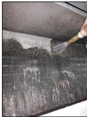
รูปที่ 3-27 เจ้าหน้าที่ทำความสะอาดเครื่องปรับอากาศ
